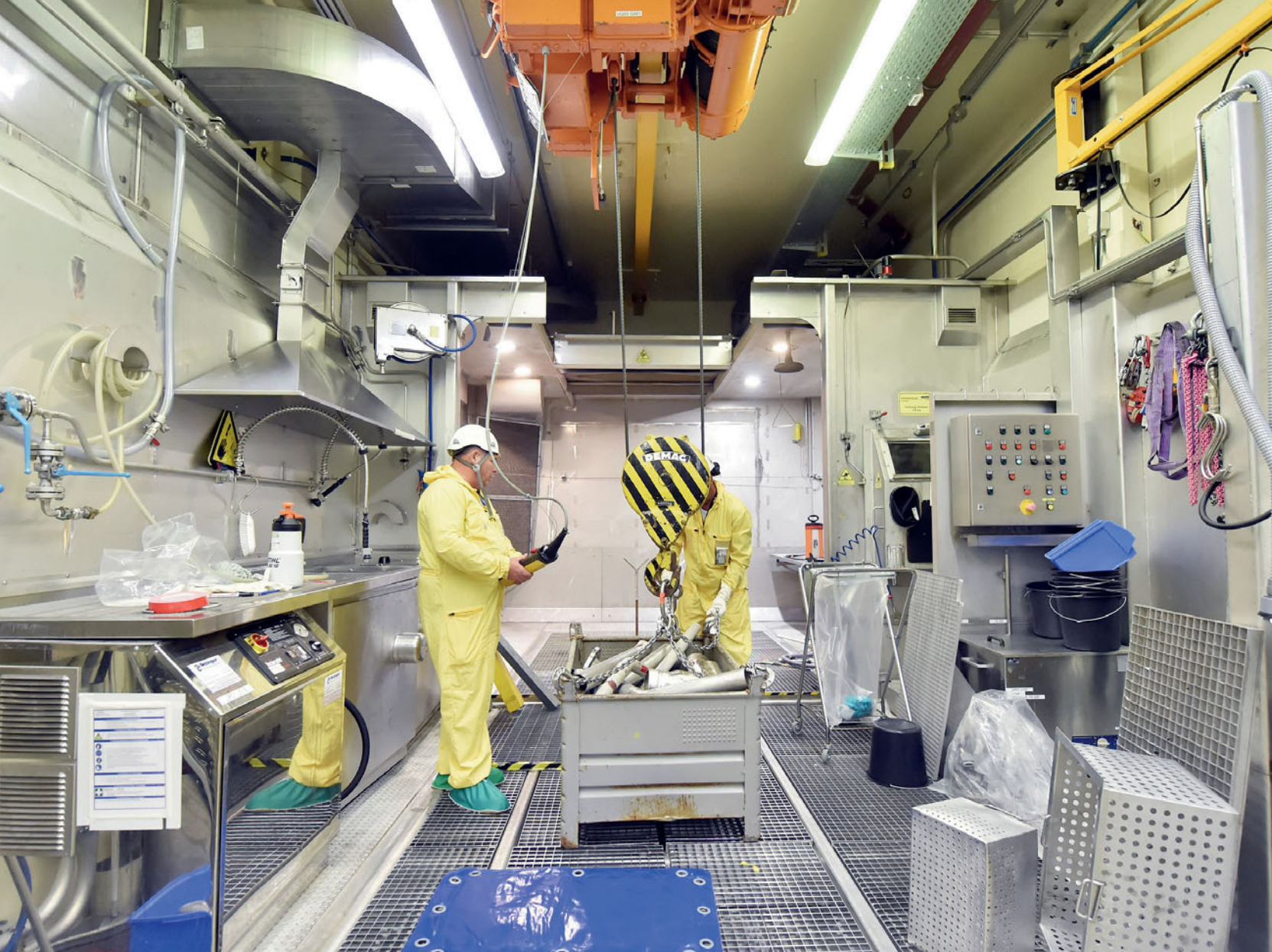
Sensible Aufgabe: Rückbauarbeiten am Kernkraftwerk Obrigheim.
