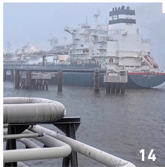
Ungeahntes Tempo: Im Dezember wurde in Wilhelmshaven das erste deutsche Flüssigerdgas-Terminal eingeweiht.
