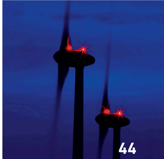
Nächtliches Blinken: Windräder leuchten im Dunkeln, damit sie von Piloten gesehen werden. Künftig darf das Warnsystem nur bei Bedarf erglühen.
