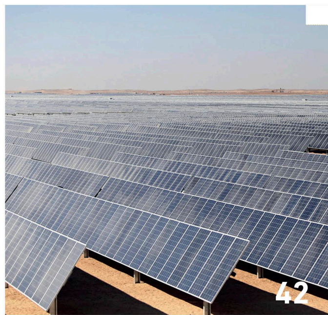
Solarer Siegeszug: Weltweit entstehen immer mehr Sonnenkraftwerke, wie hier in Ägypten.
