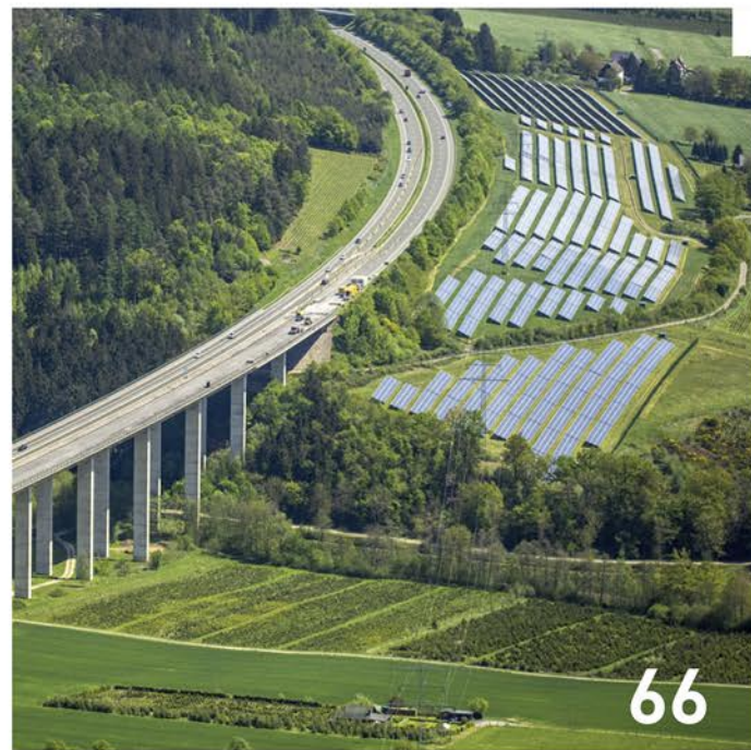
Verkehrsnah: Solarparks neben Autobahnen, wie hier in NRW, sind nicht überall erwünscht.
