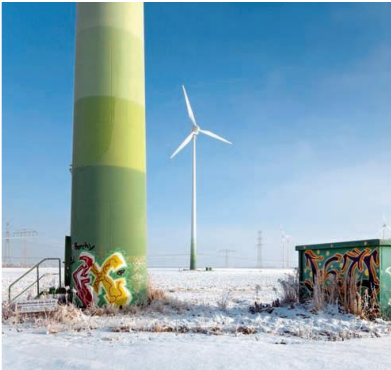
Winter im Windpark: 2010 wurde im Vorjahresvergleich rund 20 Prozent weniger Erzeugungsleistung installiert. Ein Grund dafür war die lang anhaltende Kälte – ab fünf Grad minus können keine Fundamente gegossen werden.
