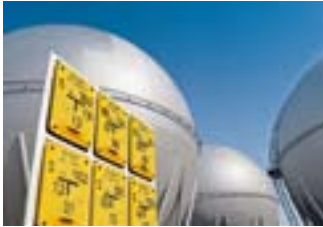
Speicherkugel: Überirdisch wird Gas nur noch selten gespeichert.
