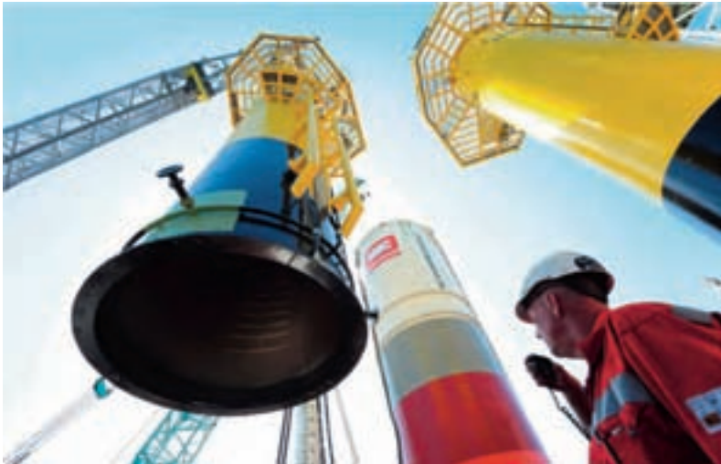
Offshore fürs Auto: Die Fundamente für den Meereswindpark Riffgatt stehen bereit. Audi will künftig aus dem Strom einiger Anlagen Methan machen.
