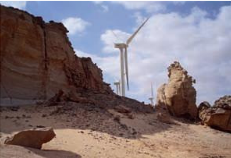
Neue Märkte: Gamesa hat Ende 2011 den Auftrag zur Errichtung von 100 Windturbinen in Ägypten gewonnen.
