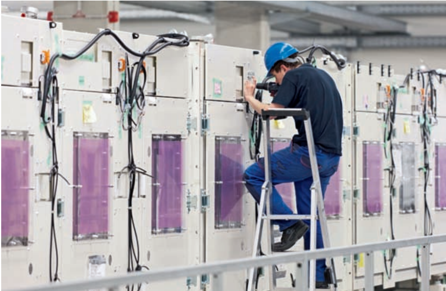
Ab in den Ofen: In der neuen Werkshalle in Kamenz richten Mitarbeiter die Beschichtungsöfen ein. Bald sollen hier pro Jahr rund drei Millionen Batteriezellen behandelt werden.
