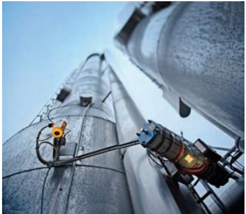
Abgetrennt: In der Absorptionskolonne löst sich das Kohlendioxid aus dem Biogas.
