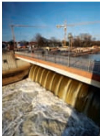
Parallelbetrieb: Das Kraftwerk ist wie ein Bypass zum Weserwehr angelegt.
