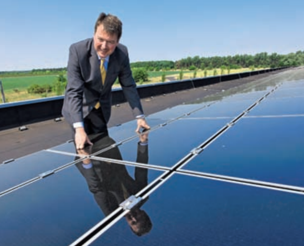
Gut Lachen: Werksleiter Burghard von Westerholt an der neuen 1,3 Megawatt starken Solarstromanlage auf dem Werksdach seiner Fabrik in Frankfurt/Oder. Ursprünglich war sie nicht vorgesehen.
