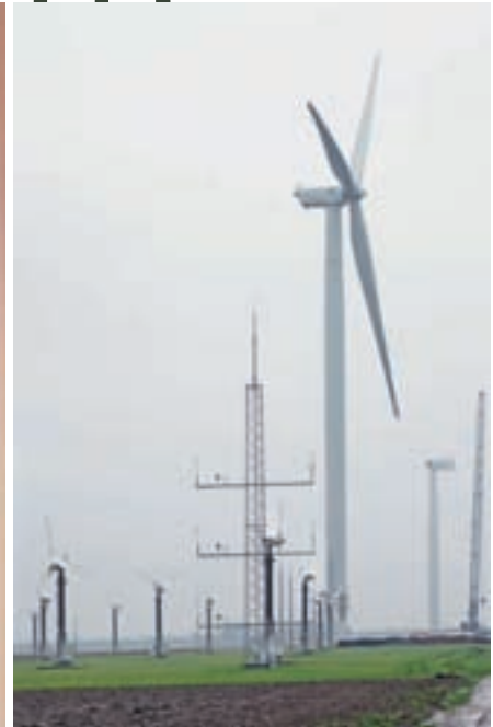
Upsizing-Studie: Kleinwindkraftanlagen simulieren einen Offshore-Meeresswindpark im ECN-Testfeld Wieringermeer.
