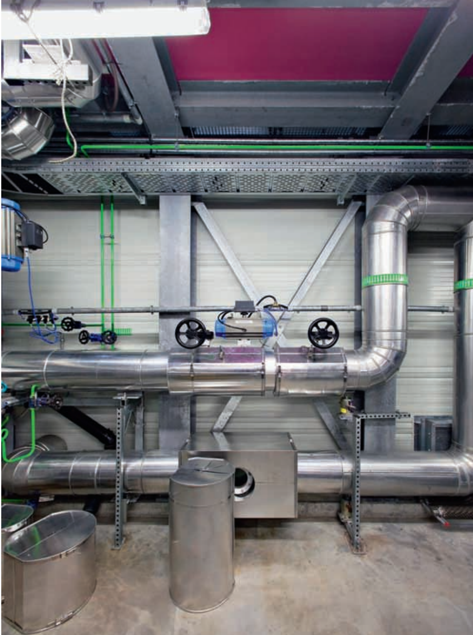
Energieleiter: Durch diese Röhre soll heißes Thermalwasser in das neue Geothermie-Kraftwerk in Bruchsal fließen.
